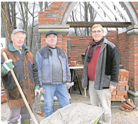
An der Kapellen-Baustelle (von links): Wilhelm Rademacher, Alex Meier und Josef Meier.
