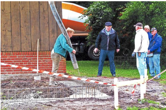
Unter den Augen des Bauleiters Willy Krechting werden die Fundamente zur Erweiterung der Museumsscheune gegossen. Foto: privat
