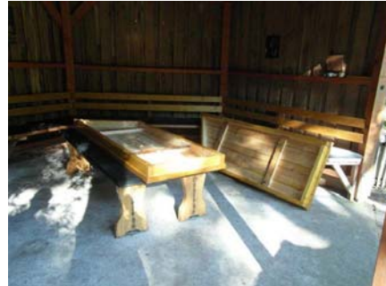
Unübersehbar: die Zerstörungen in der Hütte. (Foto: privat)
