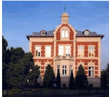
Die Villa Buchholtz wurde 1887 von dem Königlichen Landrat Wilhelm August Buchholtz (*1830 †1911) an der Heidener Chaussee (Heidener Str. 45) gebaut.
