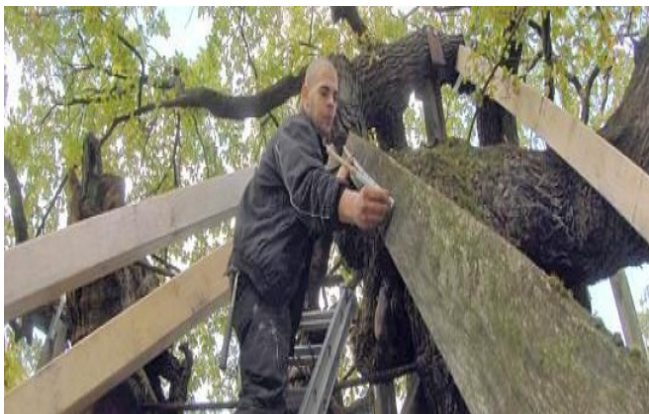
Marvin Bos vermisst den alten Balken, bevor er abgesägt wird.
