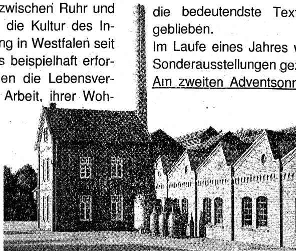
Aus „LWL-Museumstour“: Bocholter Textilmuseum. Der hohe Schornstein überragt das Kontor und den Websaal mit seinen Sheddächern.
