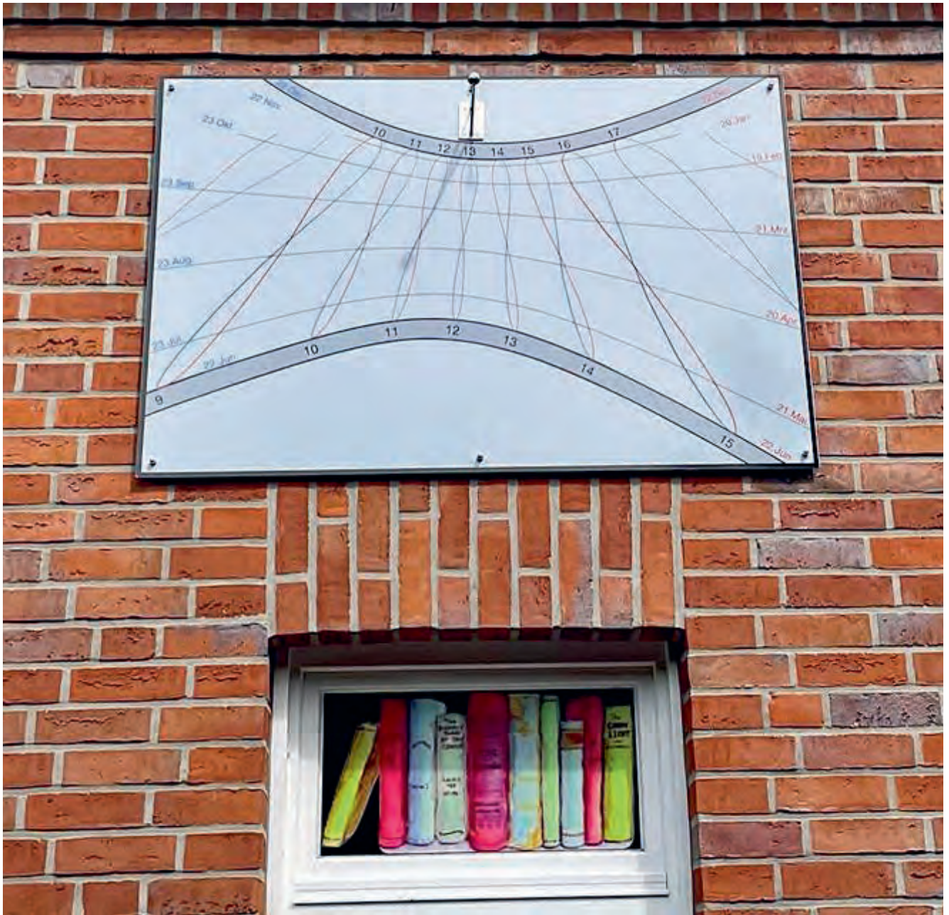
Diese Sonnenuhr wurde am St.-Silvester-Haus installiert.
