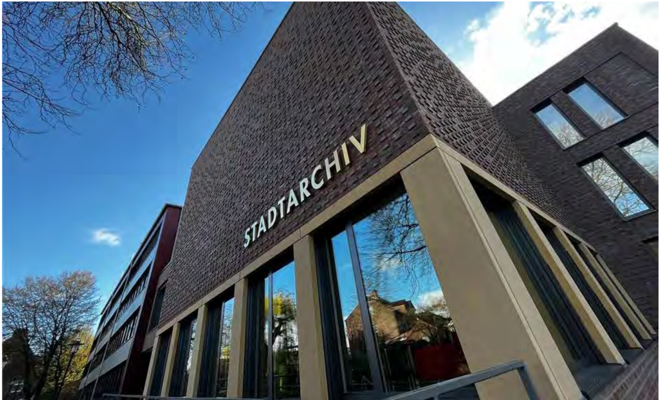
Das markante Gebäude beherbergt neben dem Stadtarchiv auch die Bauverwaltung.
